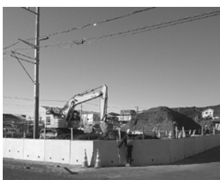
建設中の北部消防署庁舎
